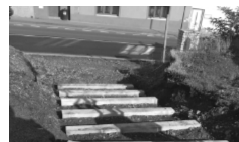
Stavba schodiště k Mladoboleslavské ulici
