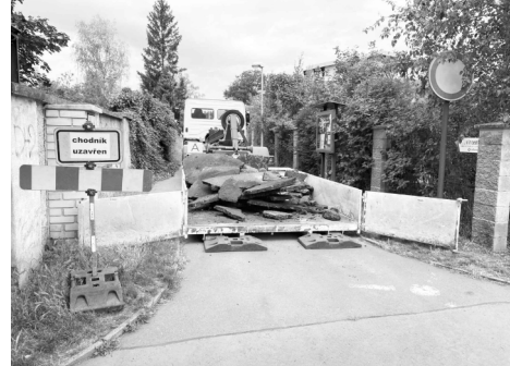
Odstraněný původní povrch chodníku
