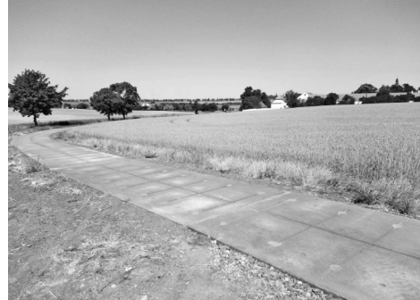
Chodník do Ctěnic z panelů
