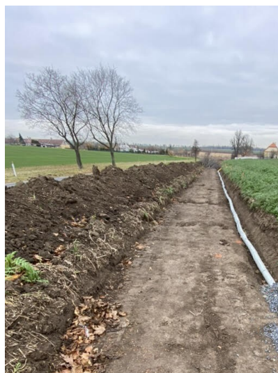
Stavba chodníku Vinoř-Ctěníce podél ulice Bohdanečská (od Farmy Vinoř)
