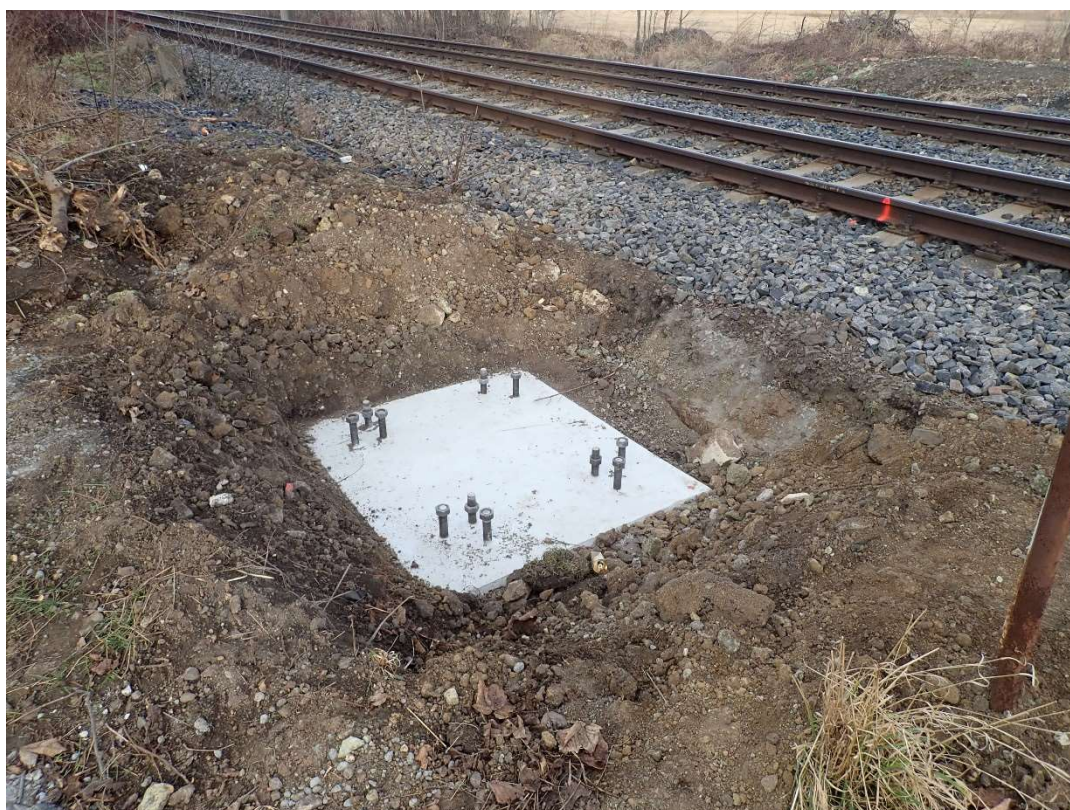
Foto 4 – Nové základy pro připravované umístění trakčních stožárů
