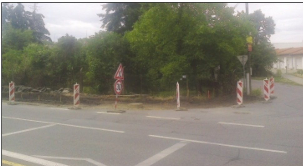
U budoucího obchodního domu Billa se buduje nová autobusová zastávka, kde budou společně zastavovat autobusy z Brandýsa i Přezletic.
